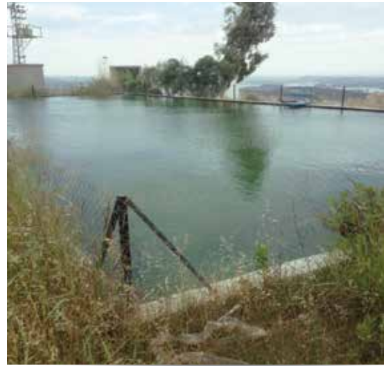
Sucular Agregası Ocağı Su Toplama ve Çökeltme Havuzu
