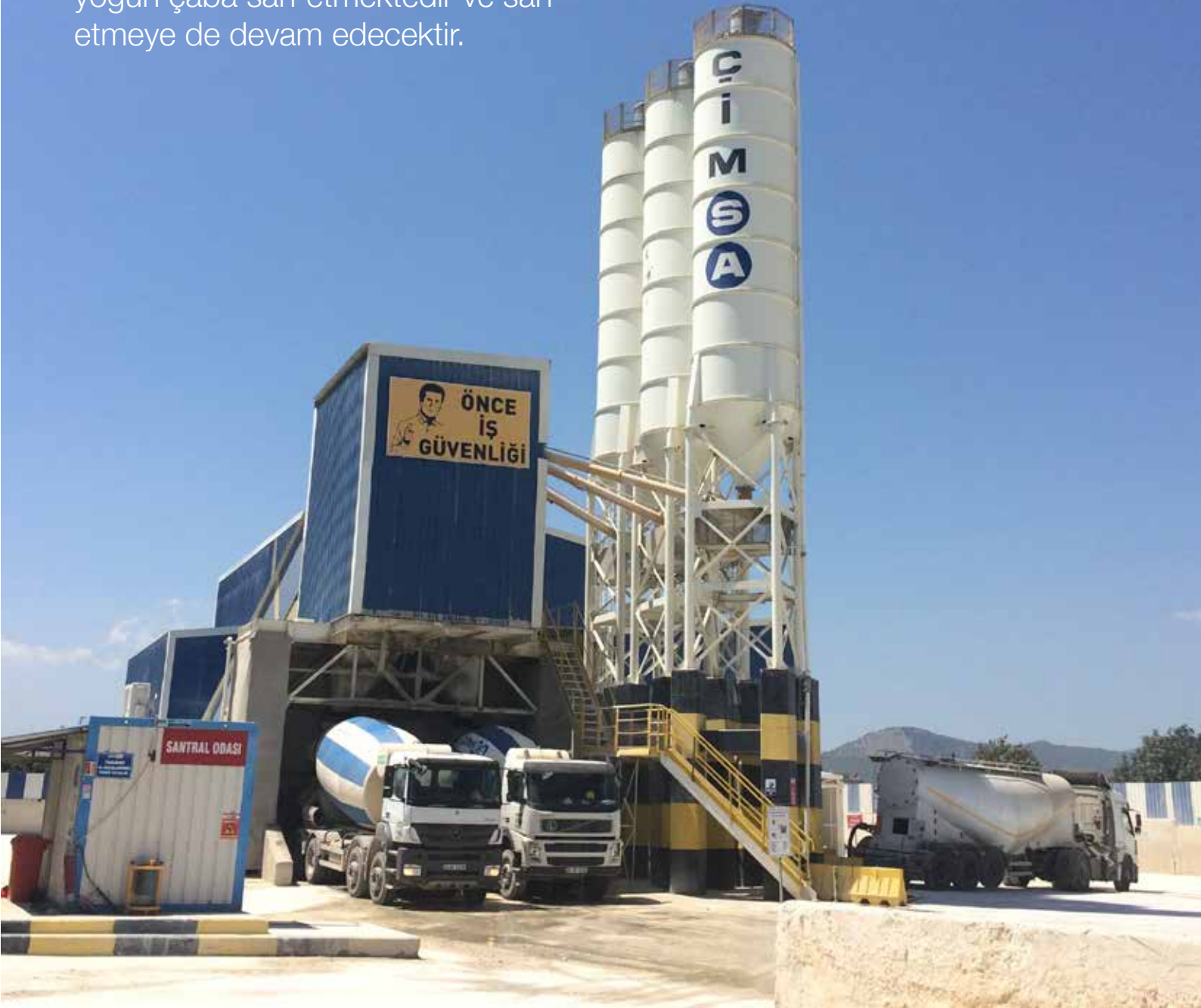
Silifke Hazır Beton Tesisi
