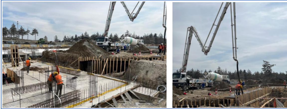
Şekil 3. AIGK tesisinin inşaat çalışmalarından bir görünüm
