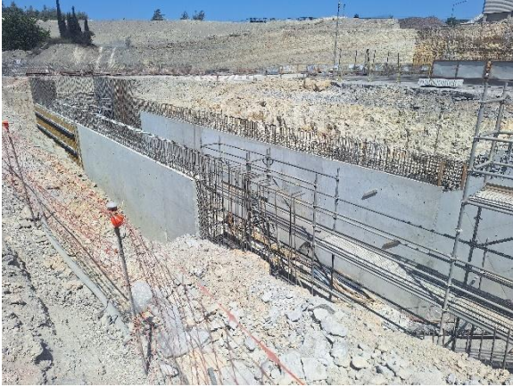
Şekil 2. 5-CAC fırını inşaat çalışmalarından görüntüler
